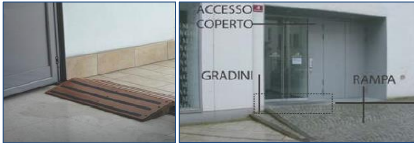
Figura 27e Figura 28 - Esempi di rampa di collegamento
